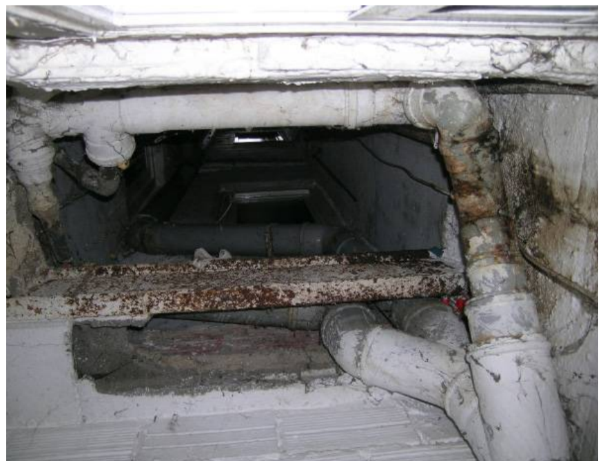
Pati de ventilació
