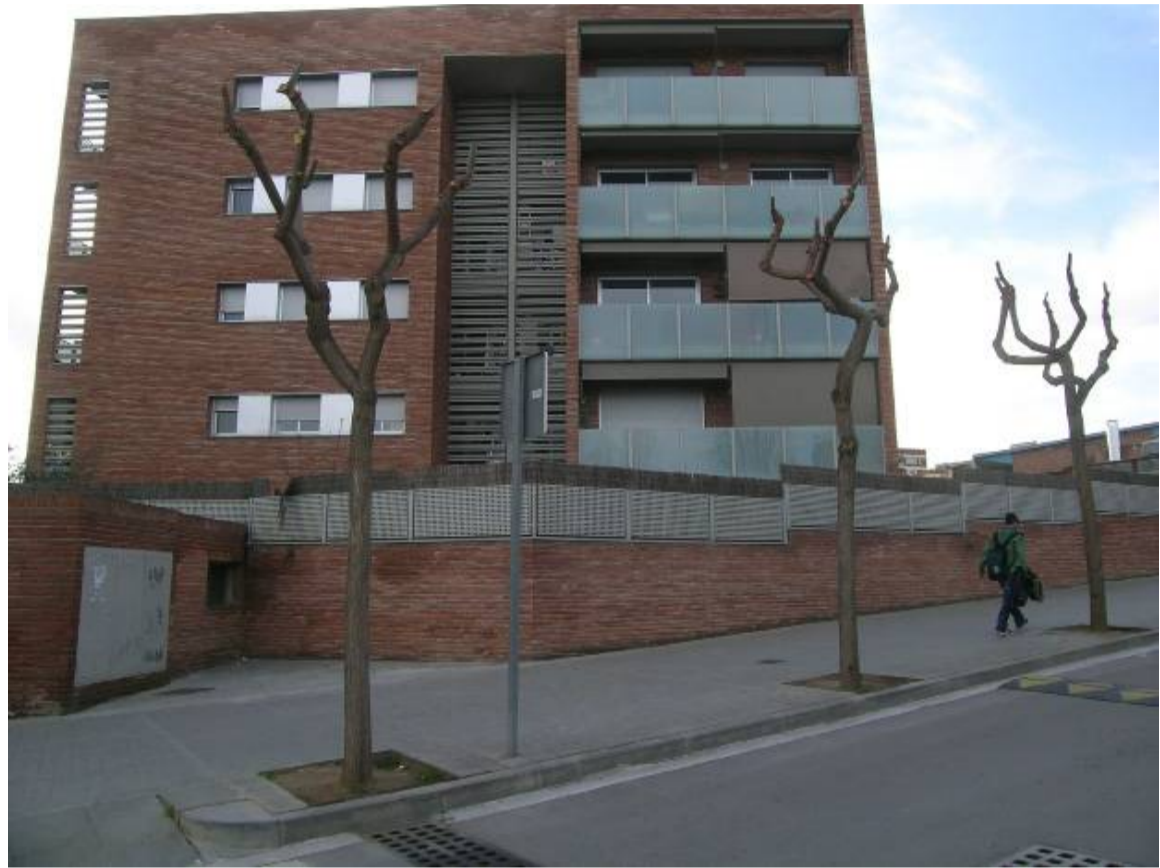
Can Farrerons. Blocs plurifamiliars aïllats
