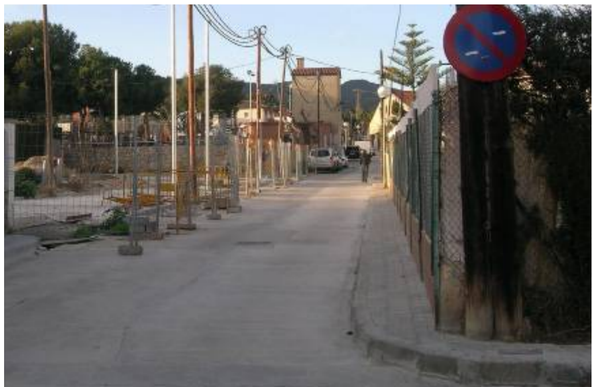
Urbanització del sector Víctor Català, actualment en fase d'execució.
