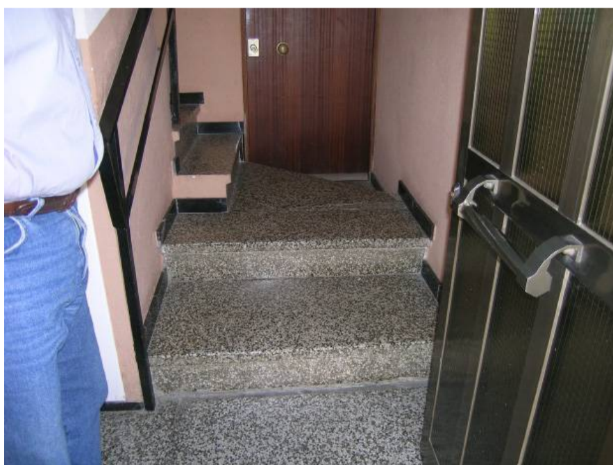
Escala interior d'edifici plurifamiliar
