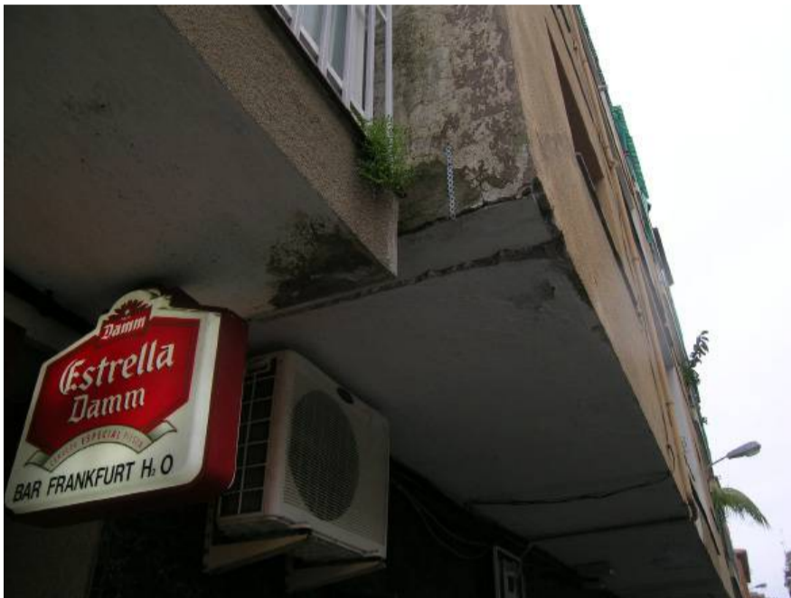
Escrostonament de revestiments
