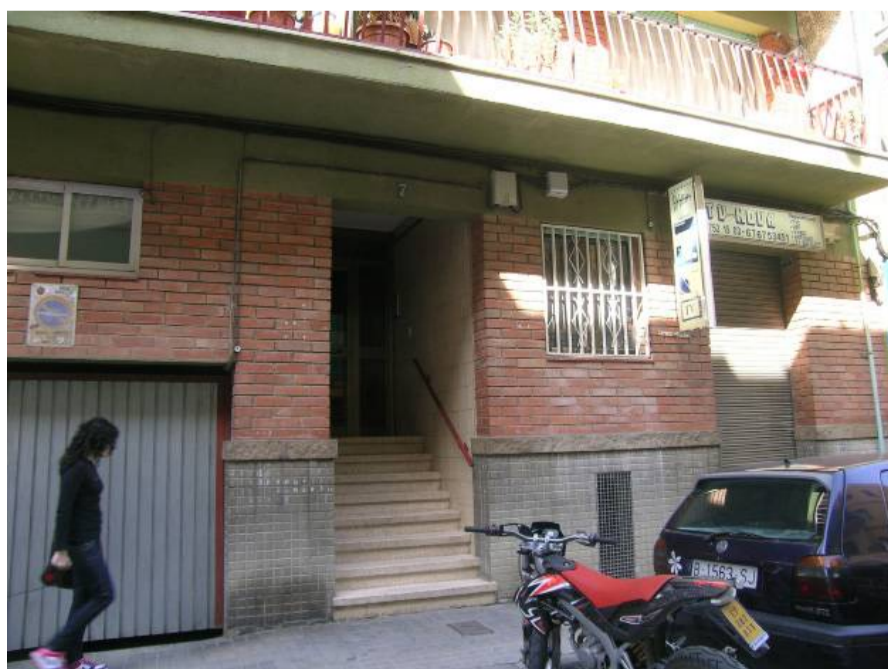
Accés a edifici plurifamiliar
