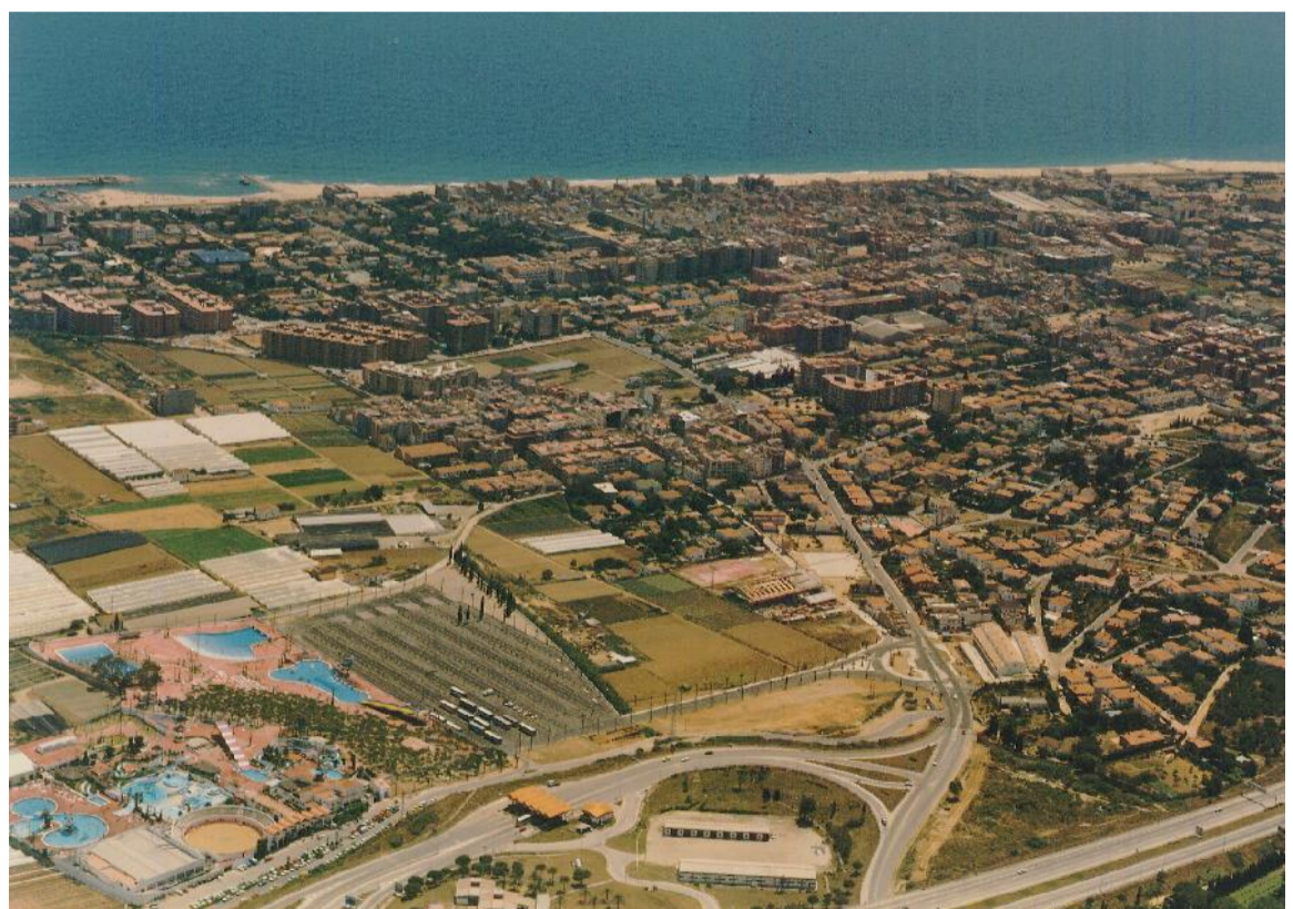
arxiu PM 1988. Foto aèria. El nus de l'autopista, Illa Fantasia i l'Escola Santa Anna en procés de construcció i davant la zona esportiva. Més enllà del Camí del Mig, el nucli compacte del Barri Cotet envoltat de conreus i aïllat de la ciutat. Al fons, els condominis organitzats sobre zones privatives i, més enllà el port esportiu, en construcció.
