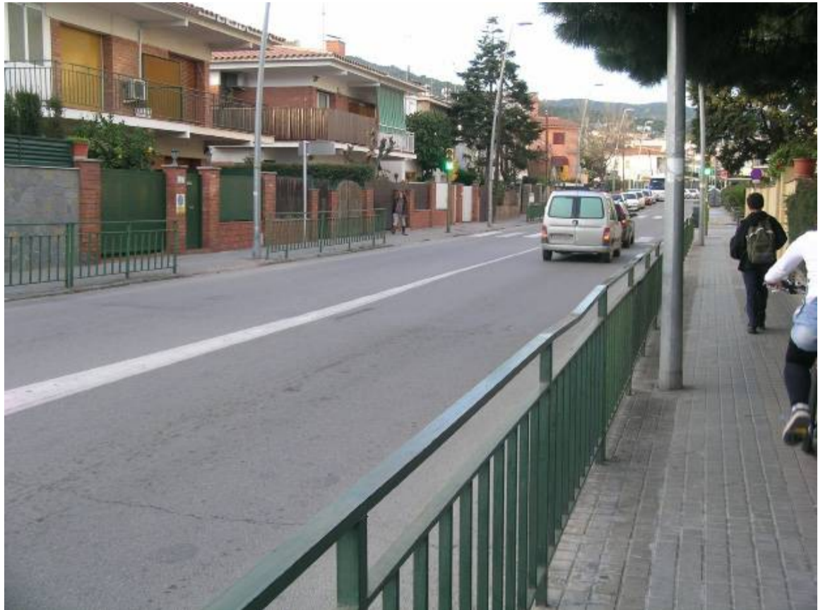
Tanques de protecció la carretera de Vilassar
