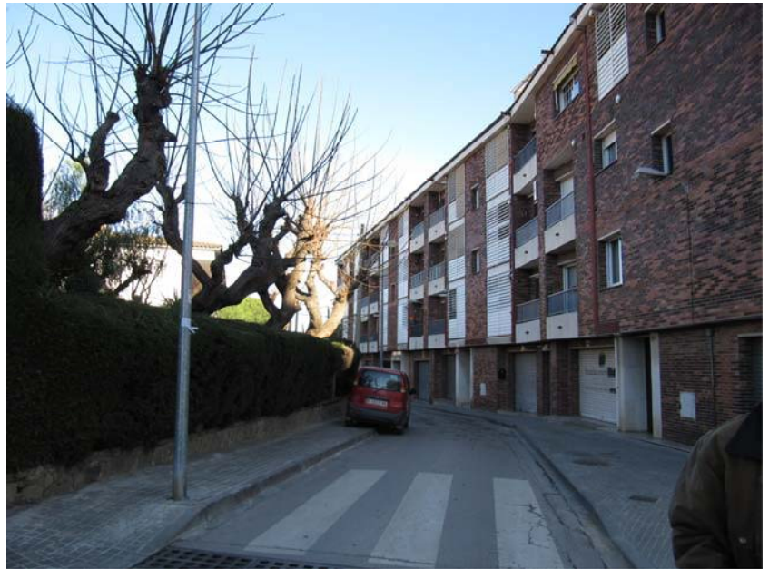
Edificacions >P+III sense ascensor al Camí del Mig
